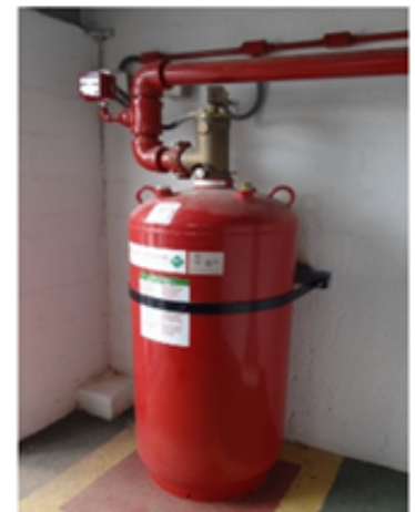
Figura 6 – Sala Elétrica tipo MIMC-MT à esquerda e cilindro FK-5-1-12 do SPCI à direita (Fonte: CEMIG) Segundo a NFPA 2001 (NFPA-2001, 2018), são considerados agentes limpos a seguir:
