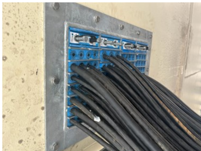
Figura 9 – Selo de vedação de cabos tipo MCT d na SE BH-São Marcos (Fonte: CEMIG)
