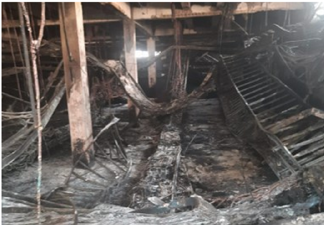
Figura 3 – Condição do porão de cabos da SE BH-Sion após incêndio (Fonte: CEMIG, 2022)
