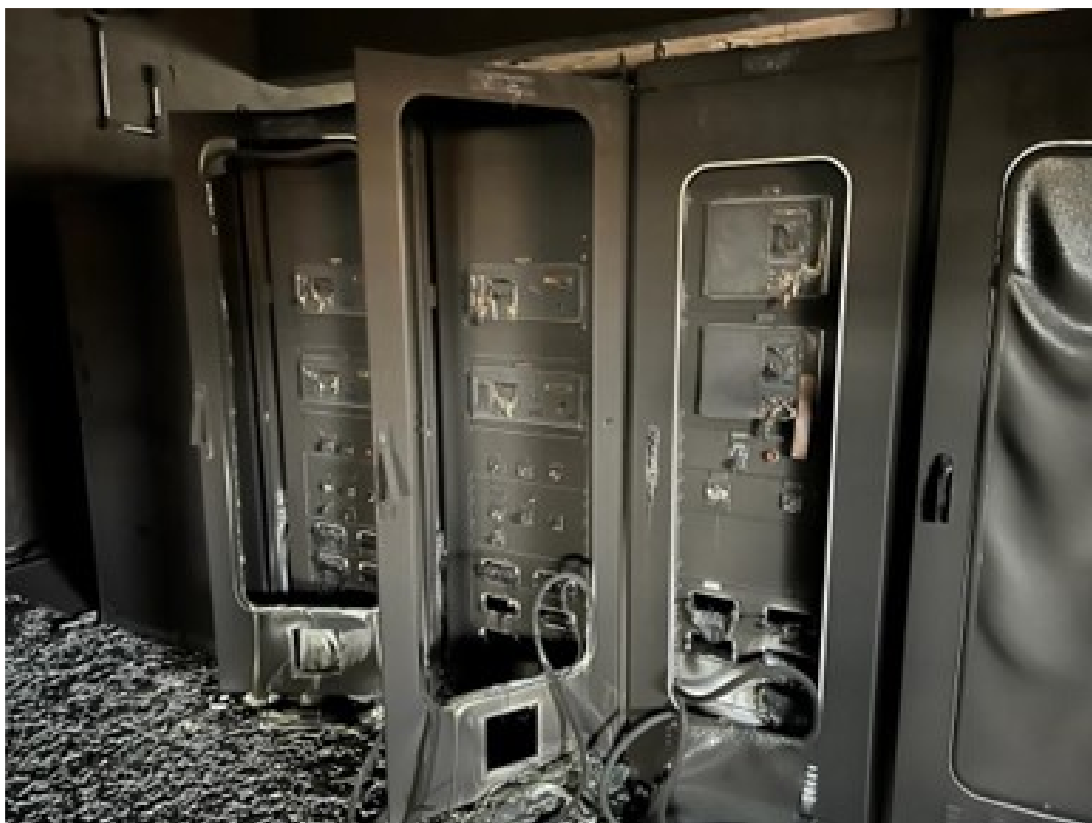
Figura 2 – Painéis de controle da SE BH-Sion após incêndio (Fonte: CEMIG, 2022)
