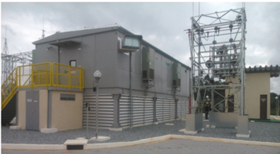
Figura 6 – Sala Elétrica tipo MIMC-MT à esquerda e cilindro FK-5-1-12 do SPCI à direita (Fonte: CEMIG) Segundo a NFPA 2001 (NFPA-2001, 2018), são considerados agentes limpos a seguir:
